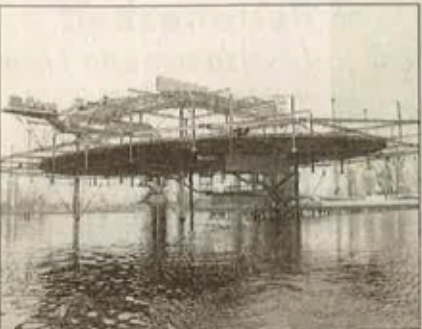
Nebulöse Stahlkonstruktion FOTO: KEY
